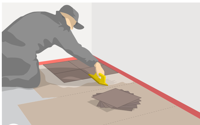
3 Aplicação do piso final (colado)
