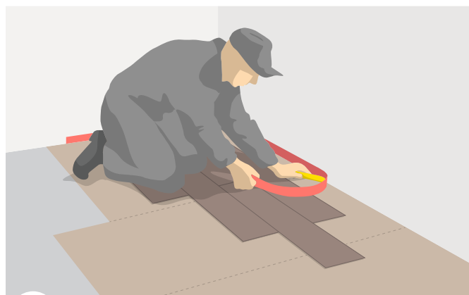
6 Corte da barreira de isolamento perimétrica
