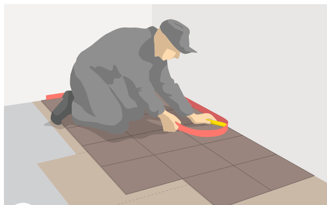
4 Corte da barreira de isolamento perimétrica
