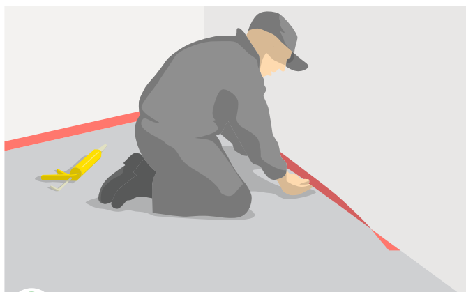
1 Aplicação da barreira perimétrica
